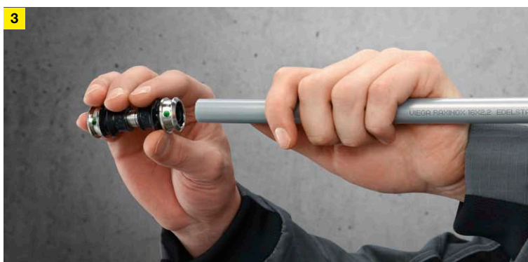
Verbinder aufstecken und Sichtfenster prüfen.
