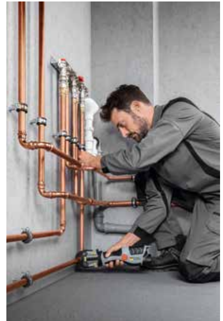
Ermöglicht dank ihrer Inline-Bauform auch die Arbeit parallel zum Boden: die Pressgun Picco 6 Plus.
