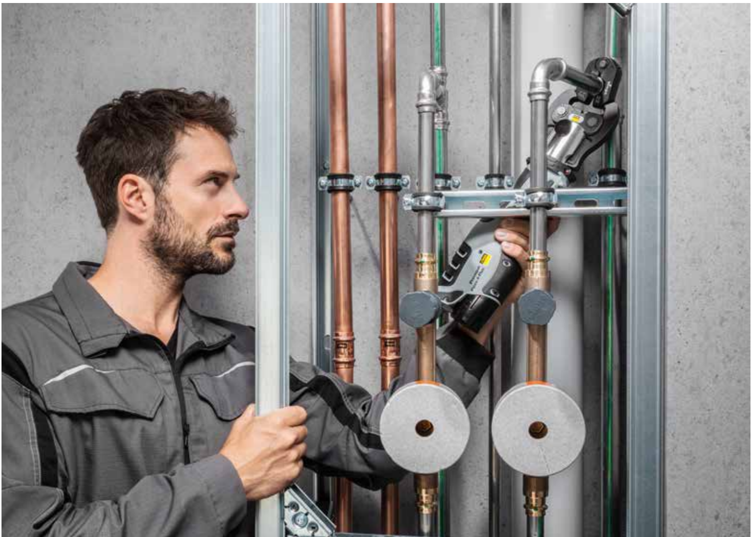
Läuft in engen Schachtsituationen zur Hochform auf: die Viega Pressgun Picco 6 Plus.
