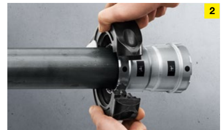
2 Zur Verpressung von Megapress-Verbindern ab 1\frac{1}{4} Zoll werden ausschließlich Pressringe mit Gelenkzugbacke verwendet. In kleineren Dimensionen zwischen \frac{3}{8} und 1 Zoll stehen sowohl Pressbacken als auch Pressringe mit Gelenkzugbacke zur Wahl.
