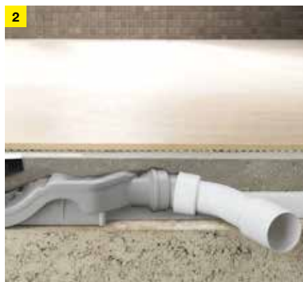
Slika 2: Izjemno ploščat: poseben odtok, namenjen sanacijam, skupno višino znižuje na 70 mm.
